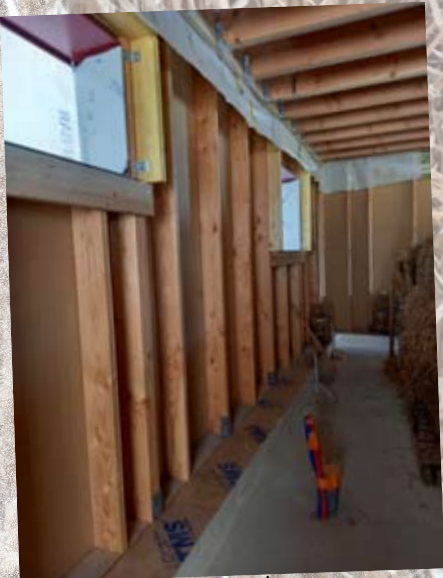
Le mur nord à isoler
