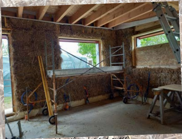
avancement cuisine (façades sud ouest)
