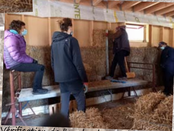
Vérification de l'aplomb pour l'enduit
