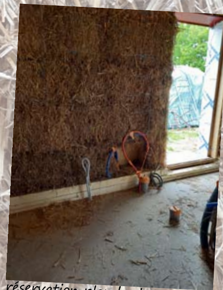
réservation plomberie pour robinet extérieur
