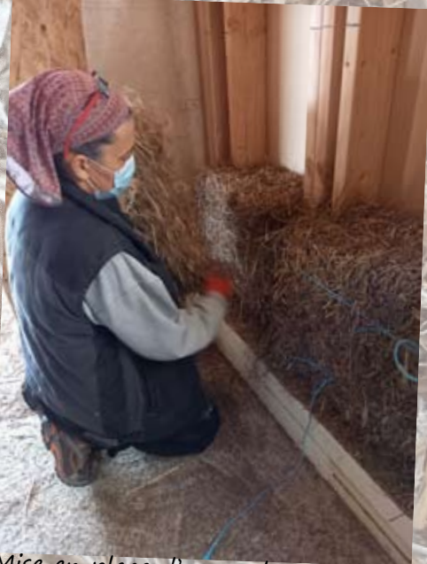
Mise en place d'une galette
