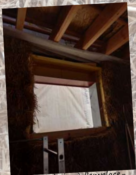
cadre provisoire à l'emplacement des dormants de menuiseries. réservation du volet roulant
