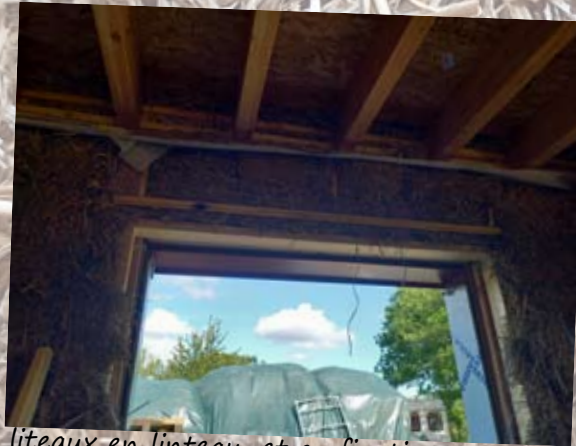
lites en linteau, et en fixation sous solives
