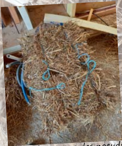
Comprimer avec des noeuds provisoires
