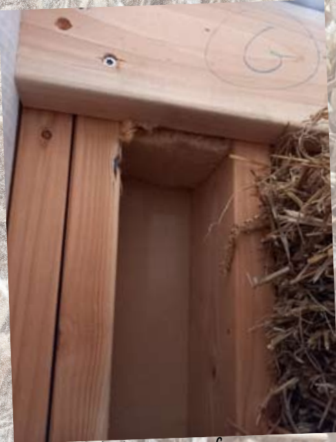
Laine de bois en sous face
