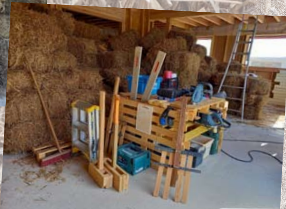
Construction de l'établi
