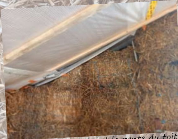
bottes façonnées suivant la pente du toit
