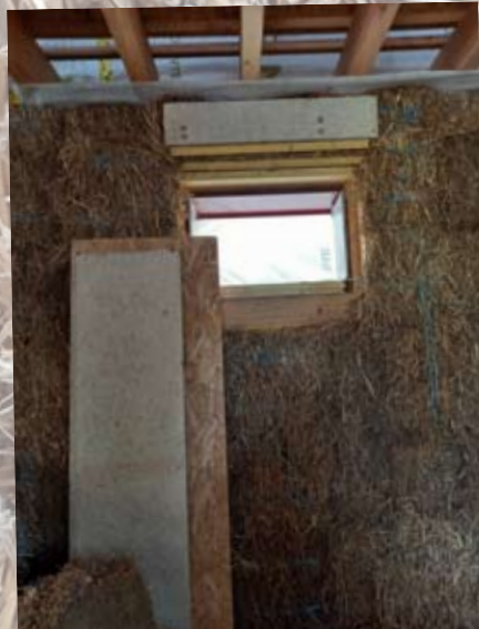
linteau: fibralith et liteaux supports de l'enduit terre
