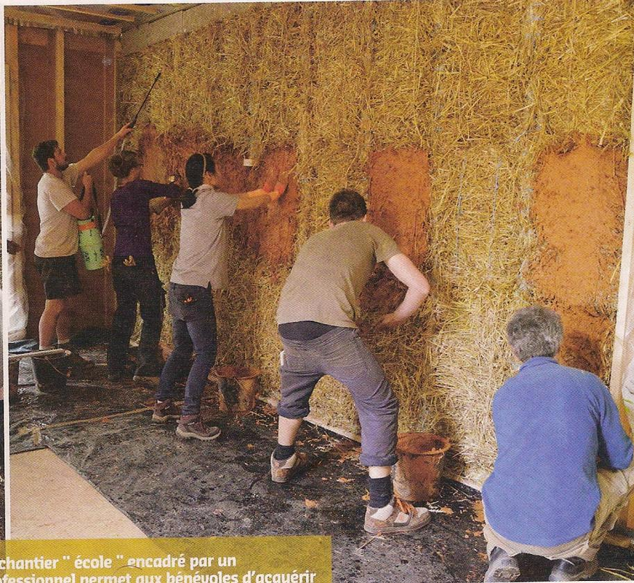
Le chantier " école " encadré par un professionnel permet aux bénévoles d'acquérir les techniques de construction en paille et de se confronter à la réalité d'un chantier.
