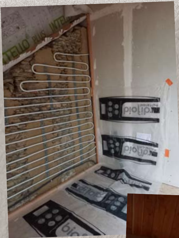
Pignon ouest Chambre 1
