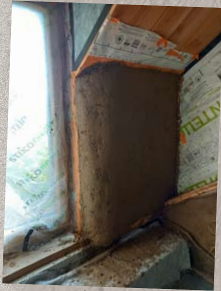
Enduit sur mur paille
