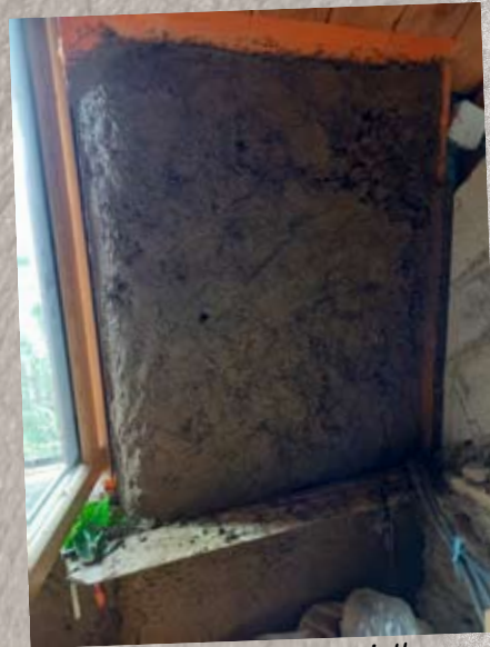
Mur de droite partiellement enduit
