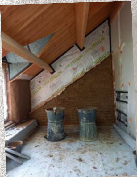
Pignon Ouest de la chambre 1
