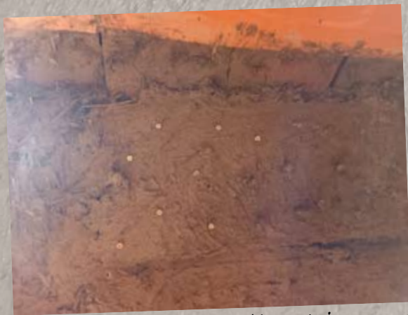
Vis supplémentaires pour l'accroche mécanique
