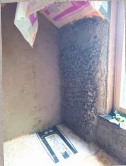
Mur de gauche partiellement enduit
