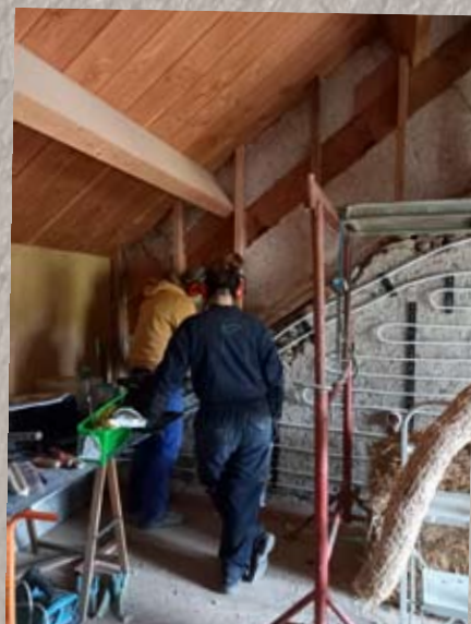
Pose des montants
