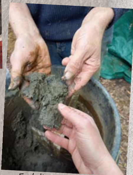
Enduit terre/paille d'un an
