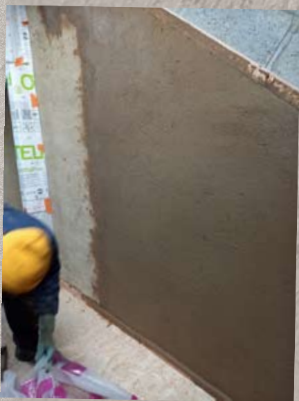
Lissage et retrait des protections
