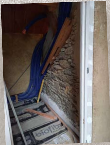
Mise en place des tasseaux
