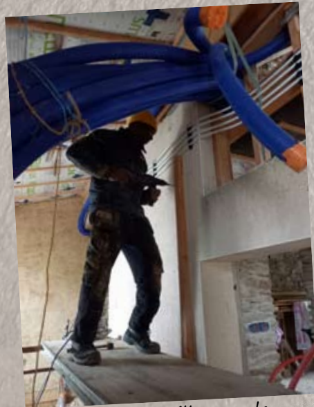
cloison terre-paille au rdc
