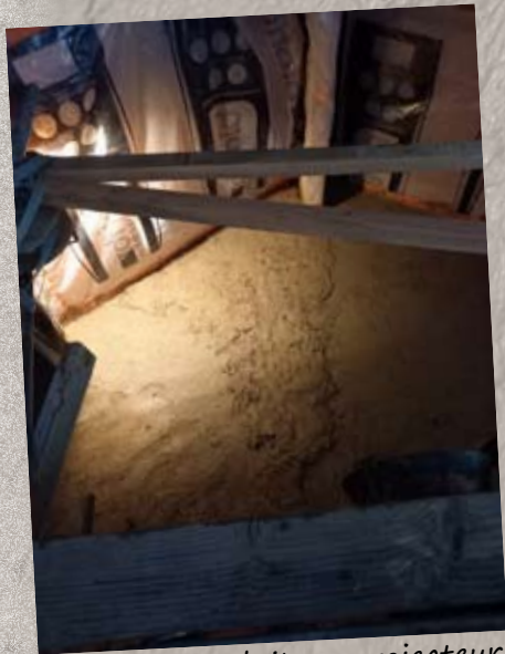
Enduit au projecteur
